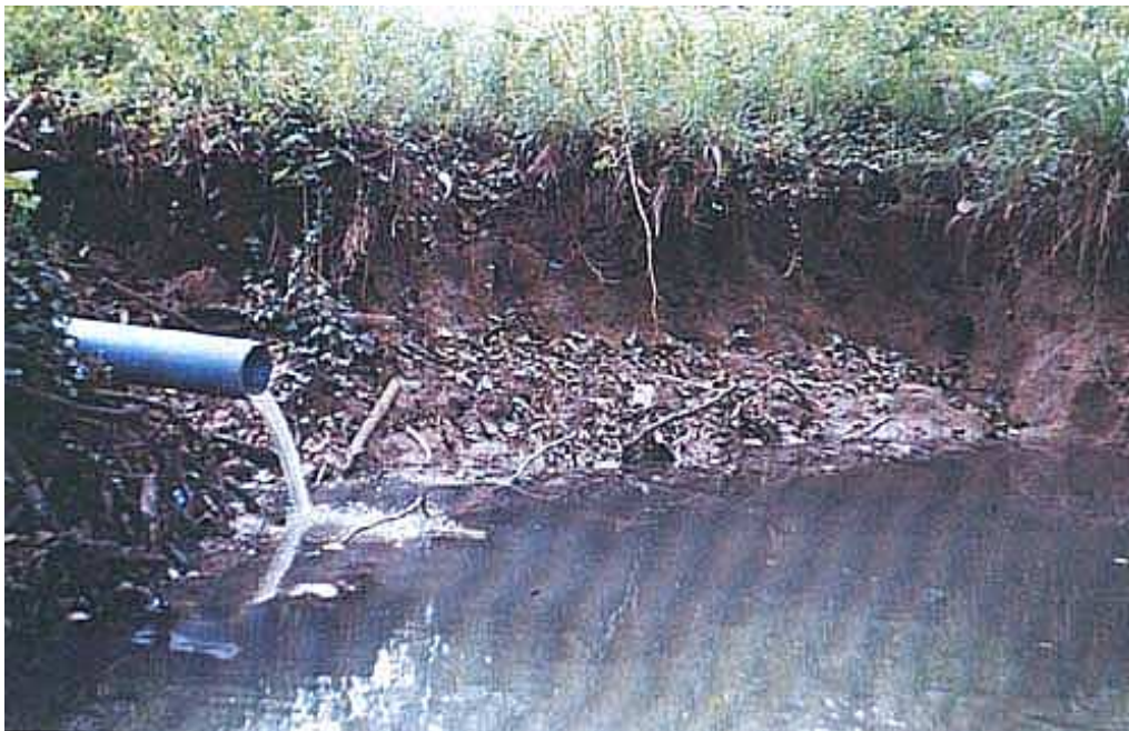
Vertido de aguas residuales al río Raices
